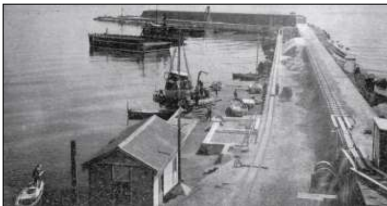
Riposto, il porto in costruzione.
